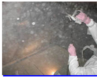
Aplicare la un canal de gaze arse, prin metoda pulverizarii airless, in doua componente
