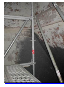
Aplicare la un canal de gaze arse, prin metoda pulverizarii airless, in doua componente
